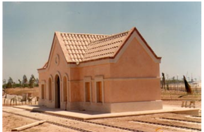
Estació del Parc de Ribes Roges en construcció - 1988
